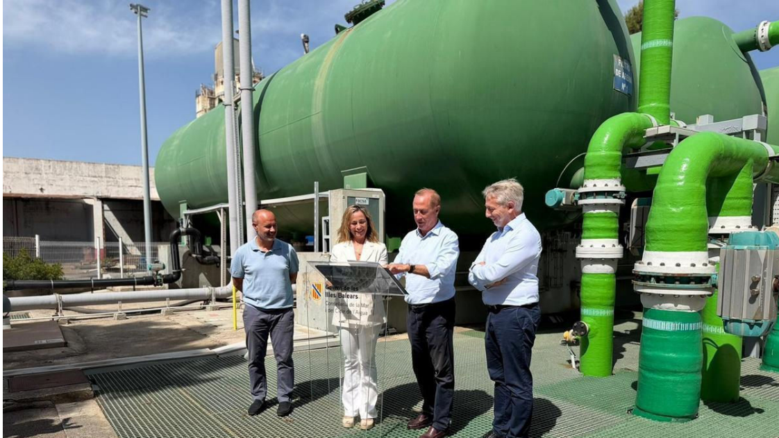
Las autoridades han firmado el protocolo en las instalaciones de la desaladora de Alcúdia. / Caib
